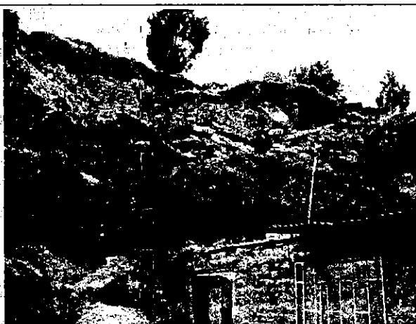
Fotografía No. 3. Talud de la parte suroccidental de la Manzana 26, en el que se son evidentes los procesos de inestabilidad relacionados con deslizamientos y la potencial caída de bloques provenientes del depósito coluvial en la parte superior de la ladera.
