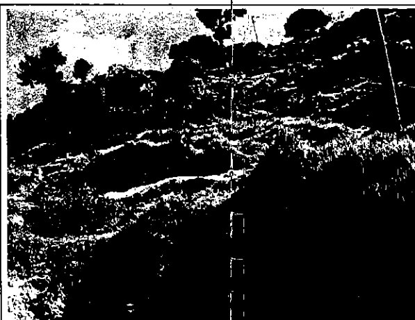
Fotografía No. 2. Aspecto del talud de la denominada Zona Verde No. 4, en el cual se aprecia la pendiente alta y la inestabilidad del área, denotada entre otros, por la superficie irregular del terreno y la pérdida de verticalidad del poste ubicado a la derecha de la fotografía.
